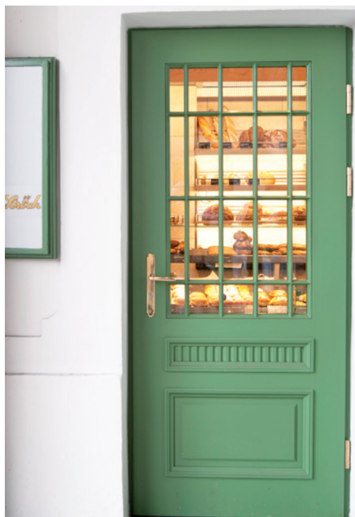
Bäckerei in Wien: Sämtliche Profile der Feuerschutztür sind detailgetreu an die ursprünglichen Türen der Wiener U-Bahn Stationen angepasst.
