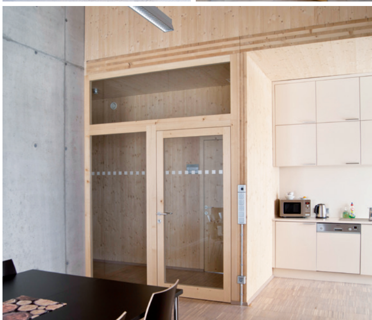
Bürogebäude im Flachgau: Die Türen in Astfichte sind als Rahmentüren mit großer Glasfläche ausgeführt.
