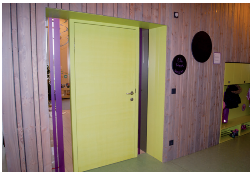
Kindergarten in Linz: Die Innentüren gewährleisten einen Schallschutz von ca. 38dB zu den anderen Räumen.
