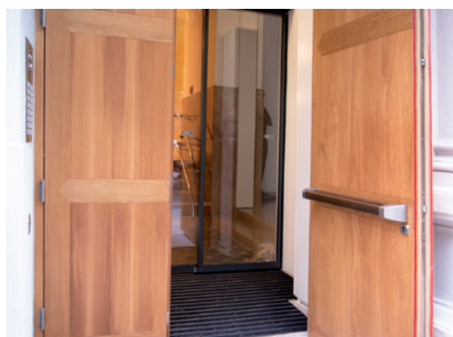
Eingangsportal Wien: 2-flügelige Eichenkonstruktion mit Panikfunktion nach EN 1125 mit Push Bar und einer Höhe von 2800 mm.
