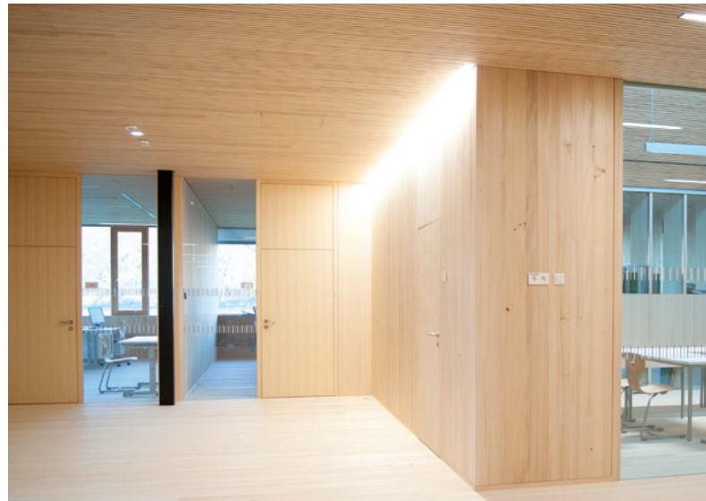
Agrarbildungszentrum in Altmünster: Die CNC-gefertigten Holztüren sind in der Brandschutzklasse EI 30 ausgeführt. Für das neue Schulgebäude wurden mehr als 300 Dachstein Feuerschutz- und Innentüren aus Holz mit Oberfläche in Tanne roh produziert.
