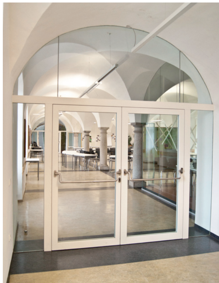
Stift Lambach: Die Glasflächen sind mit 19mm EI 30-C Glas ausgeführt und weisen auch den erforderlichen Schallschutz von knapp 40dB auf.
